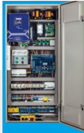
Assemblage Armoire Electrique 2016
